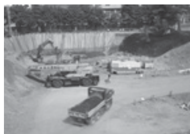
掘削工事の状況
